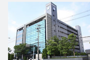
(株) 大林組 佐川印刷株式会社 本社増築工事
