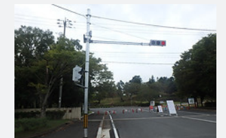
交通安全施設 信号機設置工事
