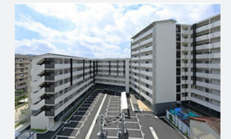
京都市 崇仁市営住宅新築工事 (下中ブロック)
